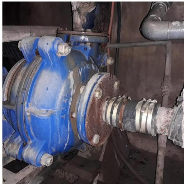
SLURRY PUMPS WERE ADDED TO THE SPIRAL PLANT OF THE WET MILL
